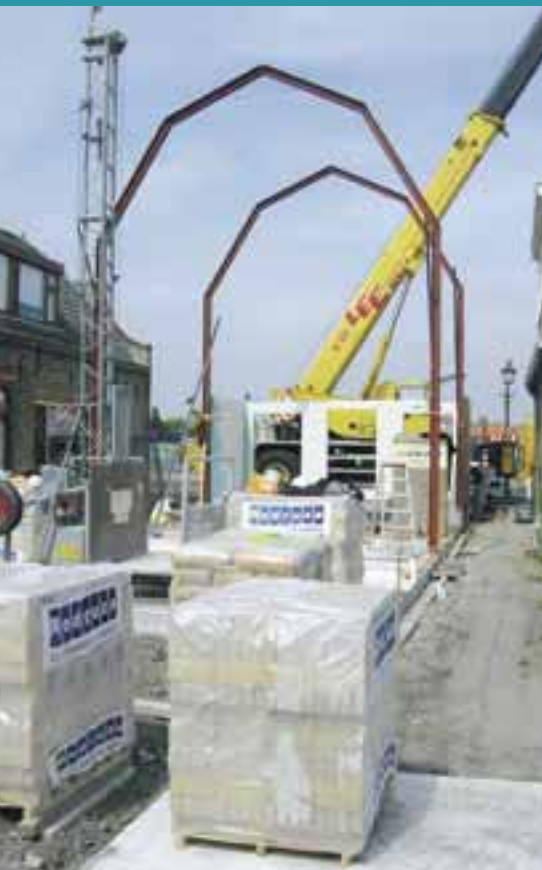
Montage prefab staalframebouw dakelementen
