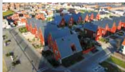
De Multiple Choice bewoners in Almere zijn zeer goed te spreken over hun staalframebouwvloer
