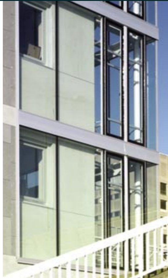
▲ Snelweggevel van gebouw de Leeuw van Vlaanderen waarop het kostenonderzoek is gebaseerd. (foto: Luuk Kramer)
